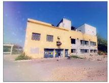
28 Demolizione del fabbricato adotto a sala questi - sala turismi, sala correzioni, servizi e spogliatoi con riciclatori e malta cementizia. Relocamento di area verde taglio vegetazione. Demolizione basamenti e manufatti fuori terra fino a -0,15m dal nuovo cortillo.
