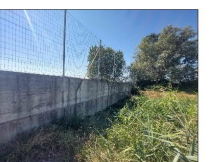
18 Demolizione muro in c.a. e cancello di area verde lato piazzale sud-ovest.
