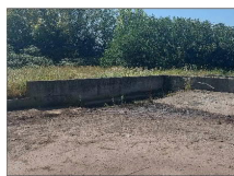
22 Demolizione muretto in c.a. e sostituzione griglia. Taglio vegetazione e abbattimento alberi non tutelati. Il verde resta venoso naturale.
