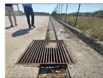
21 Doppia linea grata anti-inquinso a demolizione muretto con riciclatori e a sovrapposizione con malta cementizia. Relocamento di area verde taglio vegetazione.
