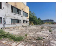
26 Demolizione fino a quota -0,15m di pavimentazione, basamenti, fondazioni con ripristino di pavimentazione bituminosa.
