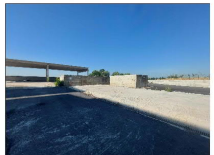
3 Demolizione corpo fossa frantumazione e definizione del materiale demolito recuperato all'interno della fossa.
