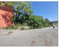
31 Vista est di tempi e piazzale avviazioni; demolizione completa compresi tutti i dati fino a -0,15m area cortiva.
