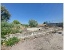
16 Ricarico di materiale depositato.
