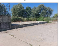
17 Demolizione basamento dimensione 15x4x0,50m realizzato con travi perimetrali in c.a., riempimento in mato naturale toc nord di cava e soletta in c.a. Sballo verifica analisi analisi del materiale prelevato non compatibile con soluzione.
