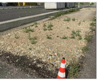
32 Scalfia materiale di riporto e pavimentazione bituminosa fino 60cm.
