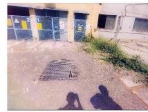
27 Chiusura del pozzetto con misto stabilizzato e ripristino pavimentazione bituminosa.
