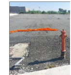
9 Rimozione termi, fontana e poia di varie manodati, carteggio DND30 per collegamento con pozzetto in c.a. in posizione (*) con tubazione in inox.
