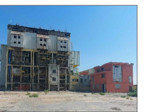
25 Vista Sud. Demolizione di avanzamento in c.a. e rimozione cancellatazioni di linea FAV per impianti e tubazioni. Demolizione impianti e fogni laterali linee di involucramento. Demolizione di basamento, manufatti fuori terra e dell'interno di piani nelle fondazioni fino alla quota -0,15m rispetto area cortiva. Demolizione del tabacchiere adotto a sala questi - sala turismi, sala correzioni, servizi e spogliatoi.
