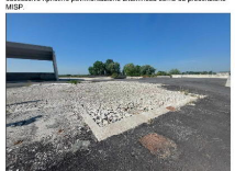
4 Demolizione della pavimentazione in disassessorio ripristino pavimentazione bituma MSP.
