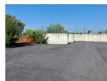
14 Demolizione setti in c.a. fino a quota -0,15m
