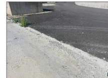
6 Demolizione della pavimentazione in c.a. fino a quota -0,15m per successivo ripristino pavimentazione bituminosa come da prescrizione MSP.
