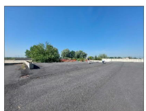
15 Rimozione fioriere, sostituzione cedrina. Sballo di qualità in zona fioriere messo in sicurezza mediante layout impianto tubosballo.
