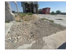
30 Ripristino pavimentazioni in c.a. lato del terraso.
