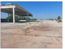
29 Ripristino pavimentazioni in c.a. Demolizione basamento cemento con successivo ripristino.
