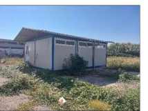
24 Demolizione soletta c.a. e rimozione base prefabbricata dopo demolizione ripristino in c.a.
