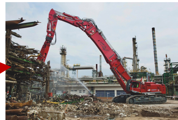
Escavatore da demolizione primaria. R-980
